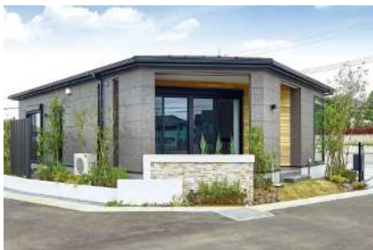
【36号棟（平屋） 外観】
