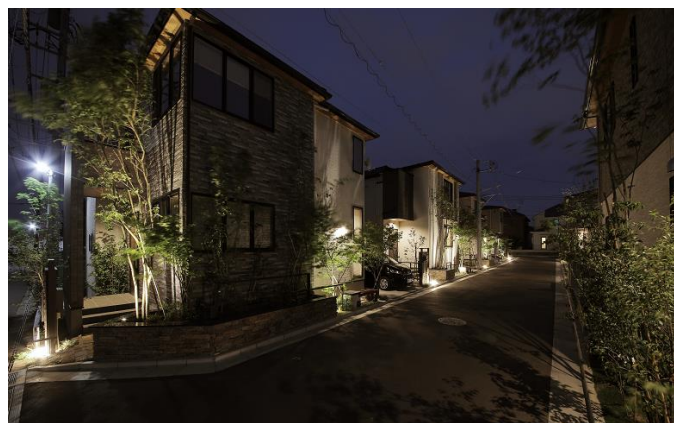
常夜灯点灯による夜の街並み
