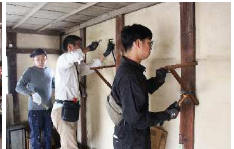
棟下式では古材リユースも積極的に行っている (築100年を超える蔵の解体にて)
