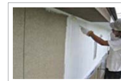
◇外壁塗装工事
