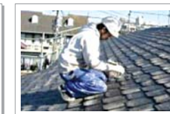
◇屋根塗装工事
