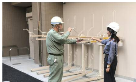
現場打合せ風景
