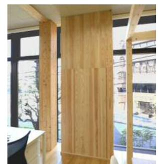
合せ柱と挟み壁(CLT耐力壁)
