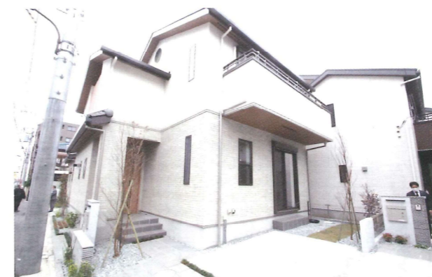
道路沿いから見た建物
