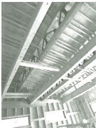
富士工場で建設中の工場事務所。STTシステムを使って大スパンを飛ばす
