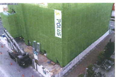
⑪3階建方工事終了 (2019.12.6)
