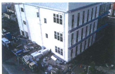
⑬外構、内部工事 (2020.2.3)
