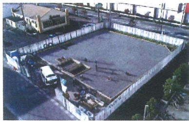
⑤基礎工事完了 (2019.10.30)
