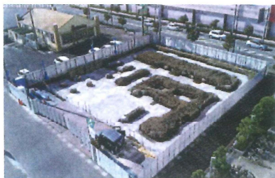
④基礎工事 (2019.9.17)
