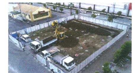
②基礎工事 (2019.9.4)
