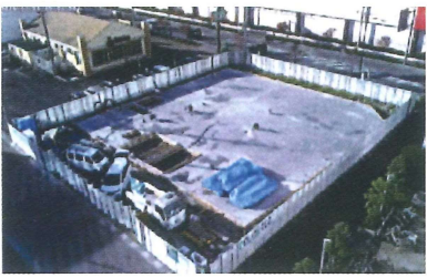
⑥配管工事 (2019.11.4)
