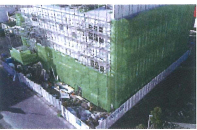
⑫足場解体 (2020.1.30)
