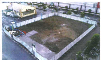
②改良工事終了 (2019.8.23)
