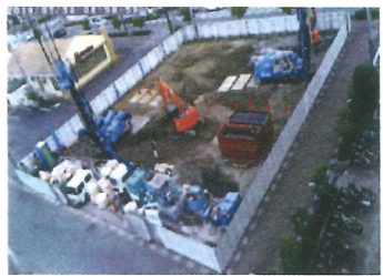
①改良工事 (2019.7.30)
