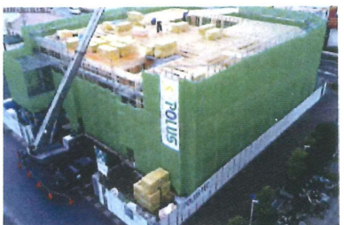
⑩2階建方工事 (2019.11.22)
