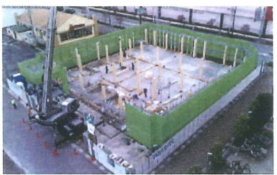
⑧建方工事 (2019.11.11)
