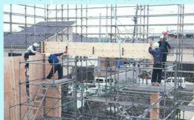
木材の仕入れから加工、施工、アフターサービスなどを全て社内で行う直営責任一貫施工体制を構築
