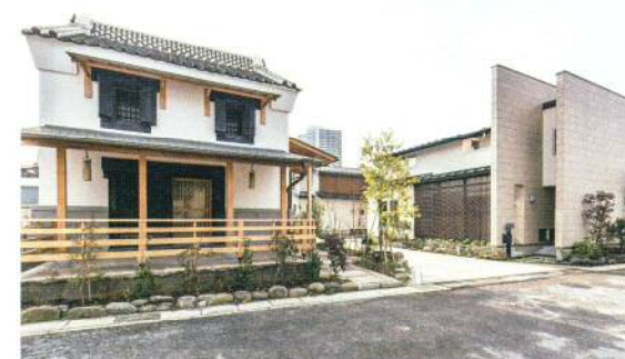
「蔵のある街づくりプロジェクト」では、蔵を再生し、越谷市に寄付した
