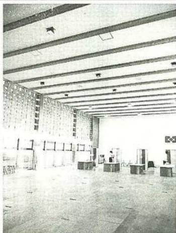
屋根構面は24mm構造用合板で剛性を高めた
