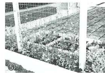
⑤ 建物の間の風の通り道に「緑化フェンス」を配置。木陰とともに植物の蒸散による冷却効果も見込んでいる
