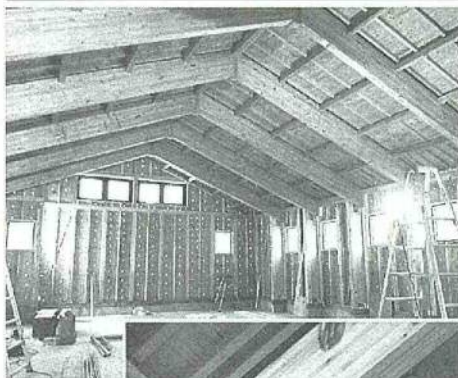
パルテノンスカイでタイバーなしの大屋根実現(上)と登り梁端部の接合
