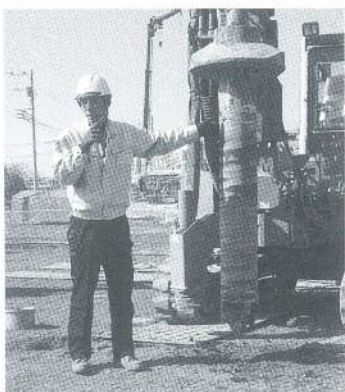
ジバテックが開発したSF-Raft工法。柱状改良に比べ10〜40%のコストダウンを実現
