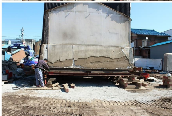
②江戸末期(推定)に建てられた内蔵を曳家で移動 第一工程…平成25年3月14日 第二工程…平成25年10月2日
