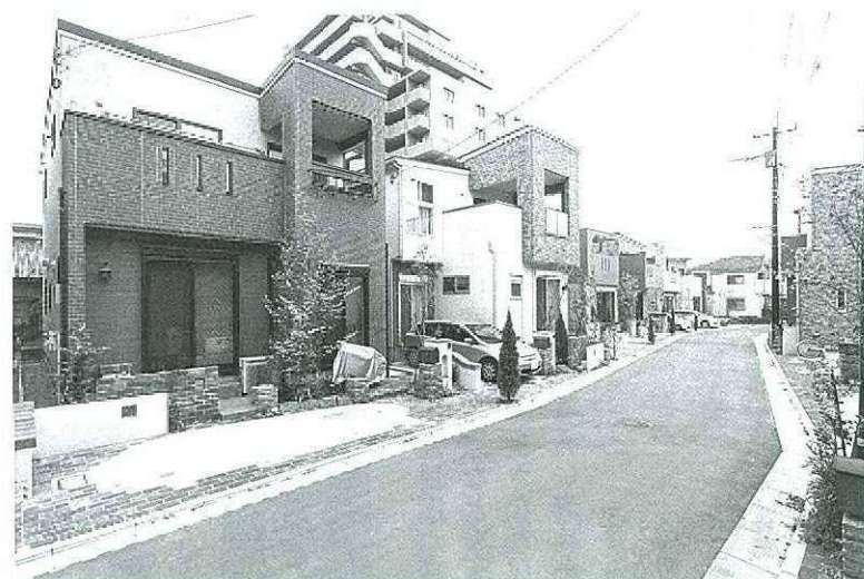
「川越CREST VILLA新座町」では全26棟を分譲
