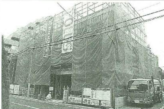
東京オアシスケア根岸（仮称）の施工現場
