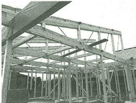
ポルトラスの施工現場（「デイサービスセンター花畑」）
