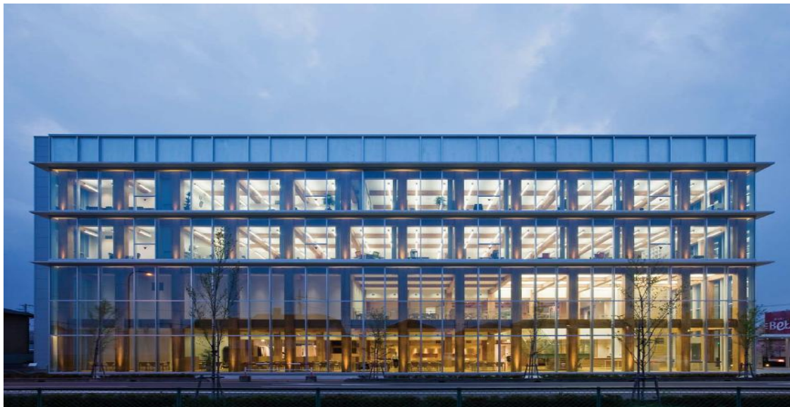
ポラテック本社ビル「ウッズクエア」外観
