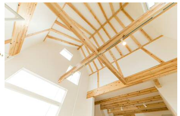
2階より小屋組みを見上げる
