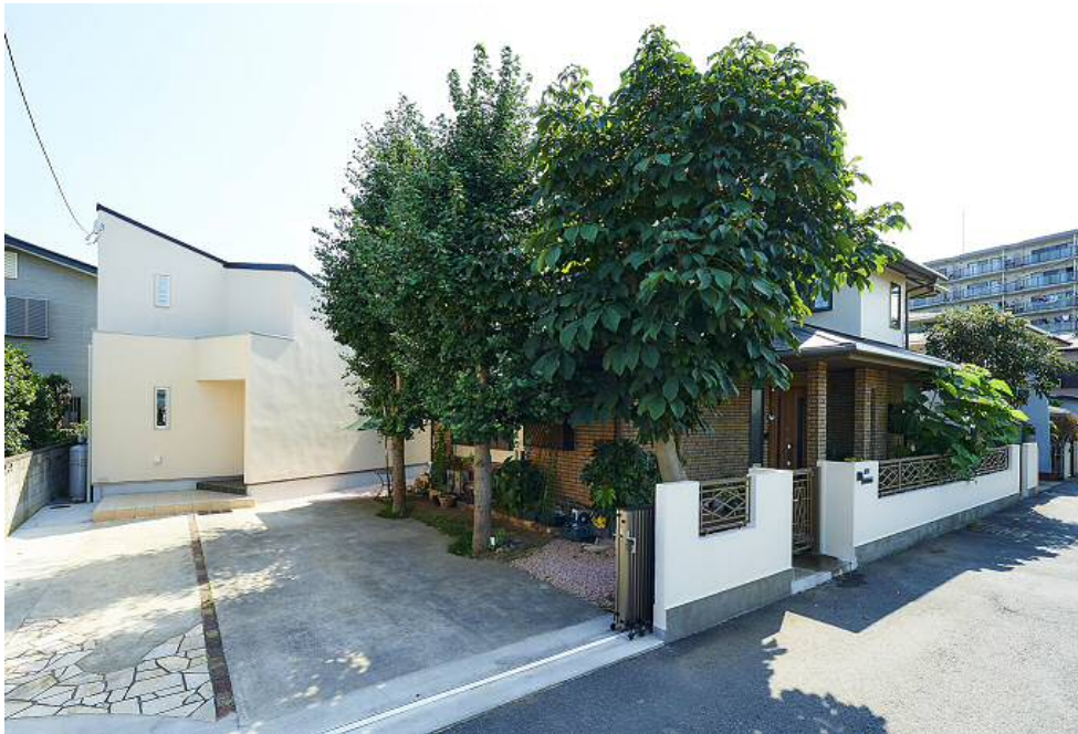
敷地境界から建物を見る/左:nestle house/右:母屋
