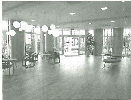
1階ロビー。CLT耐力壁を現して使用した
