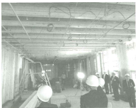
住宅用の梁部材を重ねて長さ方向に連結して長大な梁を実現
