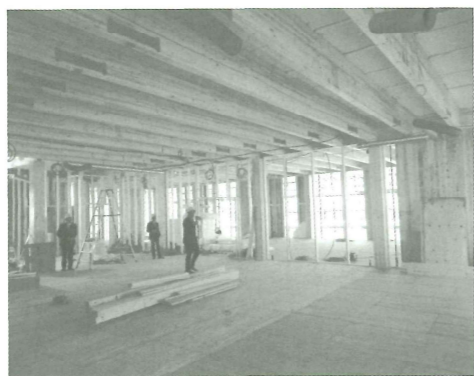
建物の空間には木造らしさが表れている
