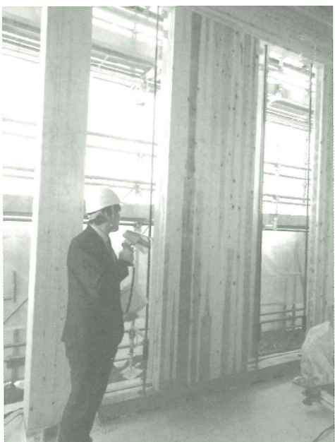
燃えしろ設計した合わせ柱とCLTの耐力壁
