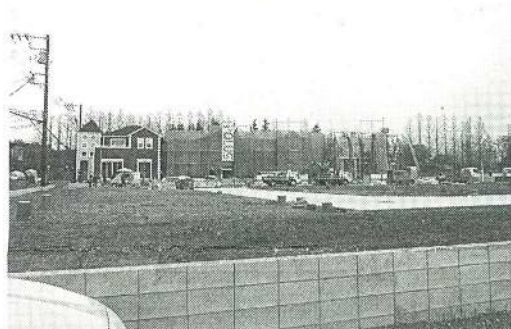
工事が進む「パレットコート北越谷 フロードヴィレッジ」
