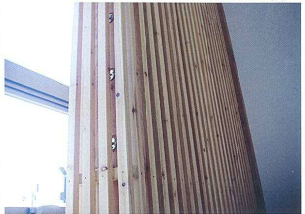
接合金物が見える耐力壁の化粧も木質となっている
