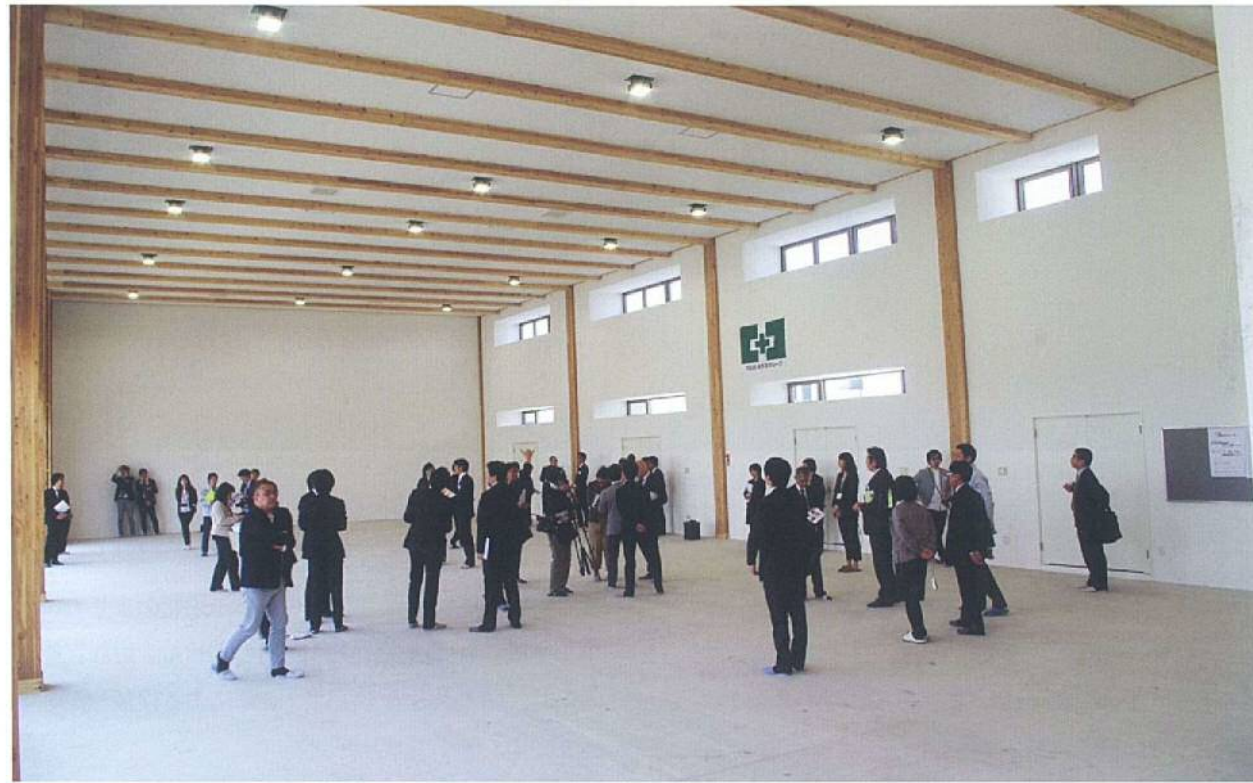
完成した実習棟 合せ柱・合せ梁・重ね梁を構造体に使用し、最大スパンは12m
