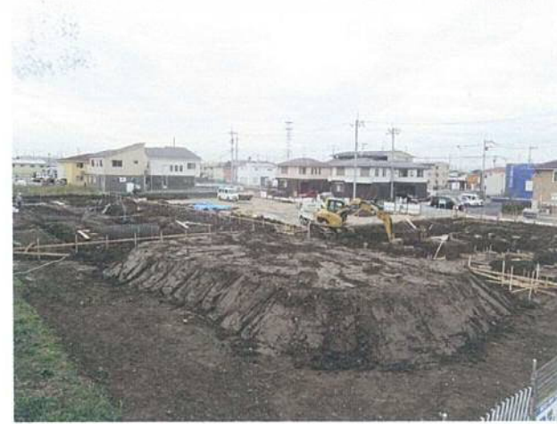
基礎工事の画像 住宅地に建っているのが良く分かる
