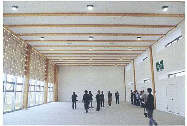
実習棟は合せ柱、合せ梁、重ね梁を表しとしている
